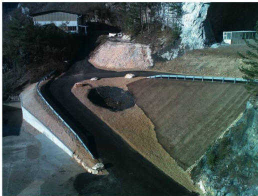
Fig. 21: Remblayage de déblais propres non réutilisables (matériaux de couleur brune sur la photo) dans les galeries des Fours à Chaux.
