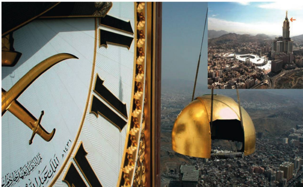
Fig. 1 : La tour de l'horloge de La Mecque en Arabie saoudite est dotée d'un télescope professionnel de 1,2 m d'ouverture, perché à plus de 400 m de sa base (flèche dans l'encart) et placé sous une coupole dorée. Photos: P. Aniol.
