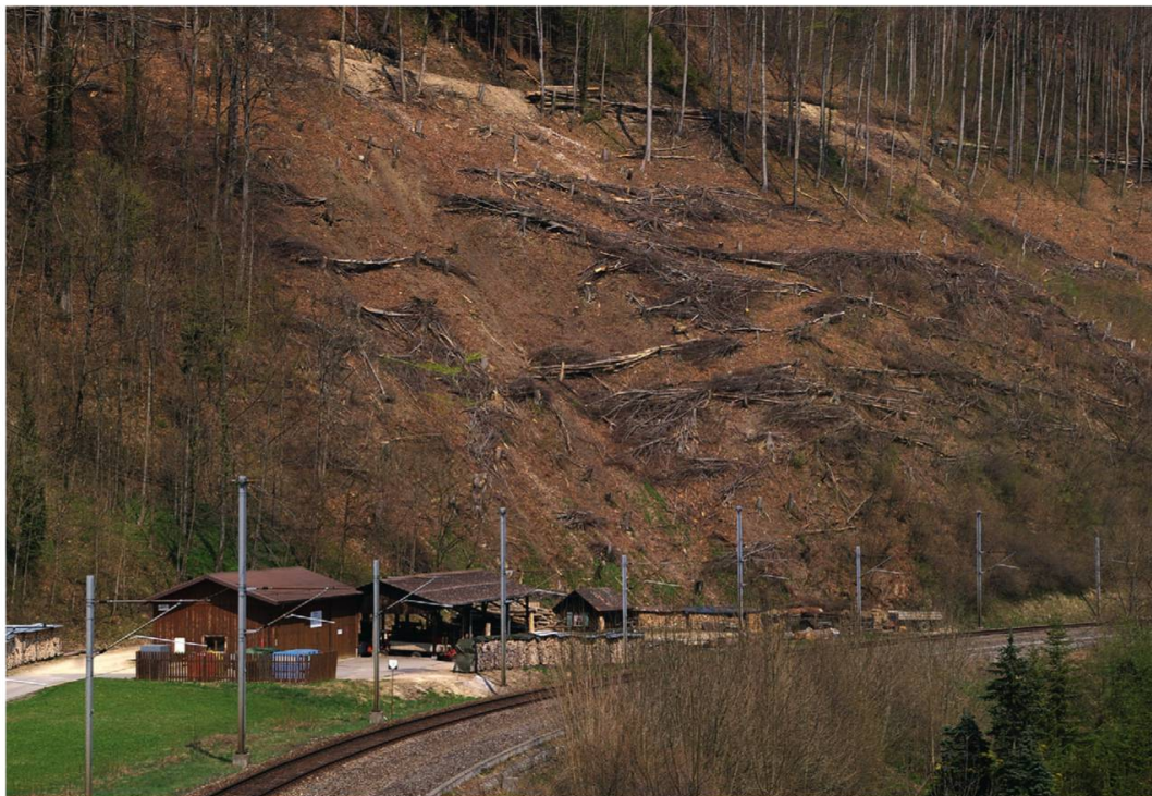
Fig. 22 : Afin de sécuriser la ligne C.F.F., une coupe de bois a été effectuée à Roches, avant la pose d'ouvrages de protection; les souches de hêtres coupés à un mètre et les bois laissés sur place serviront d'hôtes aux Rosalies des Alpes durant plusieurs années. Roches, avril 2009.
