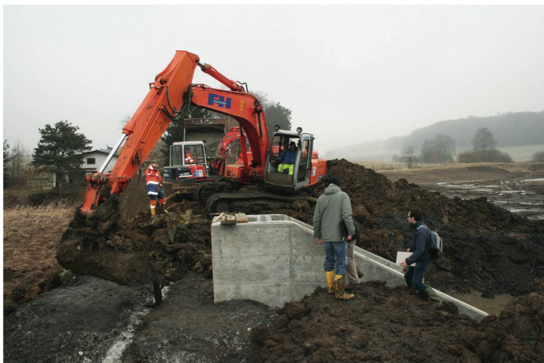
Fig. 3 : Réfection de la digue de l'étang 2, avec un muret en béton maigre noyé dans les marnes à Opalines venant du Mont Terri et la mise en place d'un système de vidange, janvier 2009.
