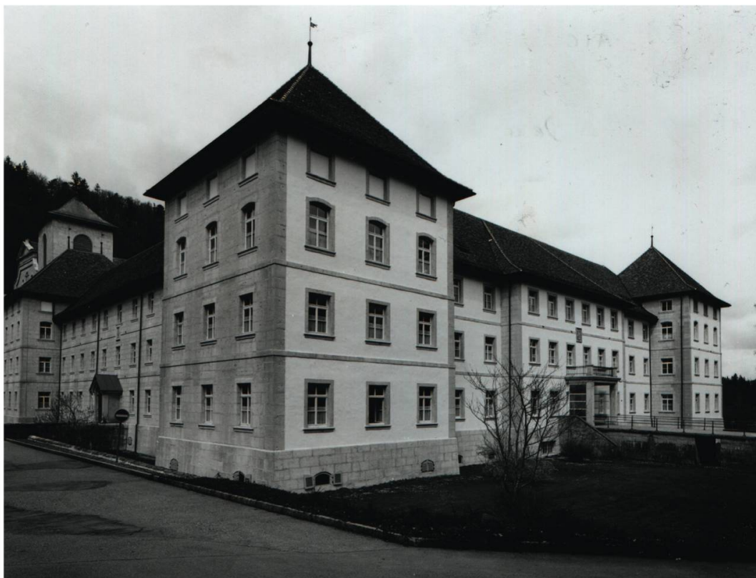
Fig. 14 : Façades après restauration (MHBE, photo Gerhard Howald).
