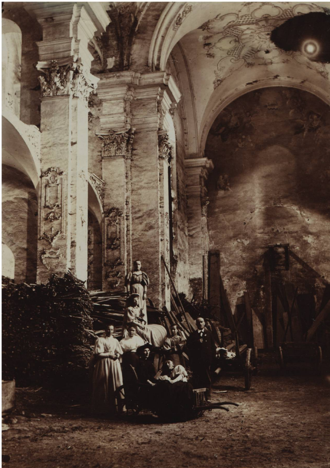
Fig. 2: L'intérieur de l'église en 1896; on distingue un grand trou dans la voûte de la travée du maître-autel (MHBE, photo Adolf Gugger).
