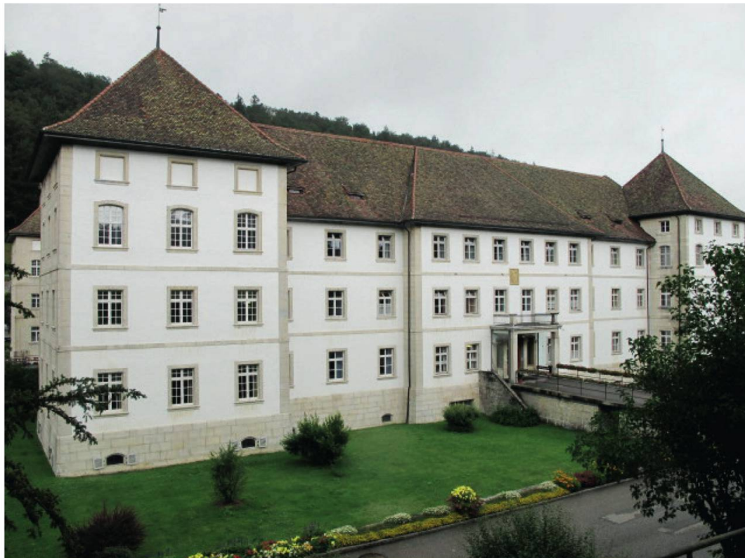
Fig. 13a, b : Façade sud avant et après restauration (photo Surdez, Malleray, 1988 ; MHBE, photo Jürg Schweizer).
