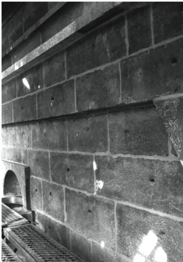
Fig. 8 : Nouveau jointoiment en chaux, 1993 (MHBE, photo Jürg Schweizer).
