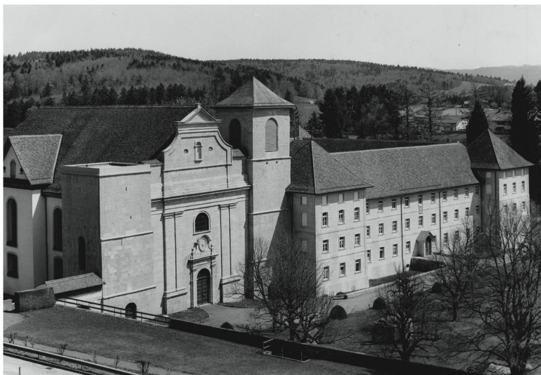
Fig. 10 : Façade ouest de l'église et de l'abbaye après restauration, état en 1998 (MHBE, photo Gerhard Howald).
