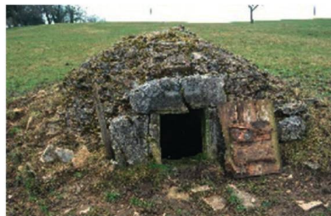
Fig. 2: Types de citernes à restaurer et à mettre sous protection patrimoniale (L. Stalder).
