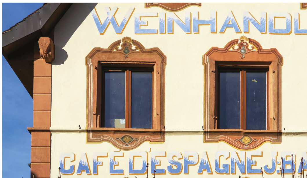
Ill. 13: Delémont, Café d'Espagne, détail de deux baies restaurées et enseignes principales.
