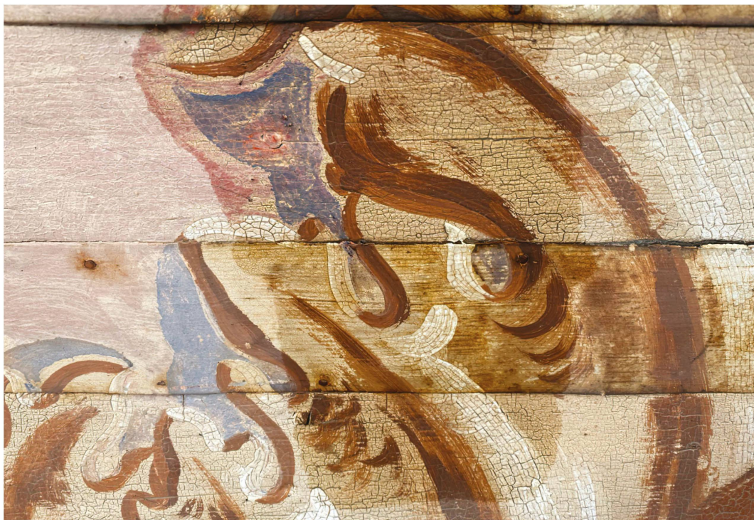
Ill. 15 : Delémont, Café d'Espagne, détail de la corniche partiellement huilée et distinction visuelle entre support de bois et de métal.
