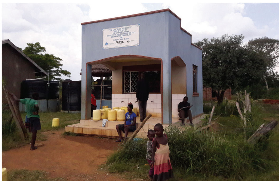
Fig. 2: Kiosque de Busime (Ouganda). À gauche les réservoirs où l'eau est traitée.
