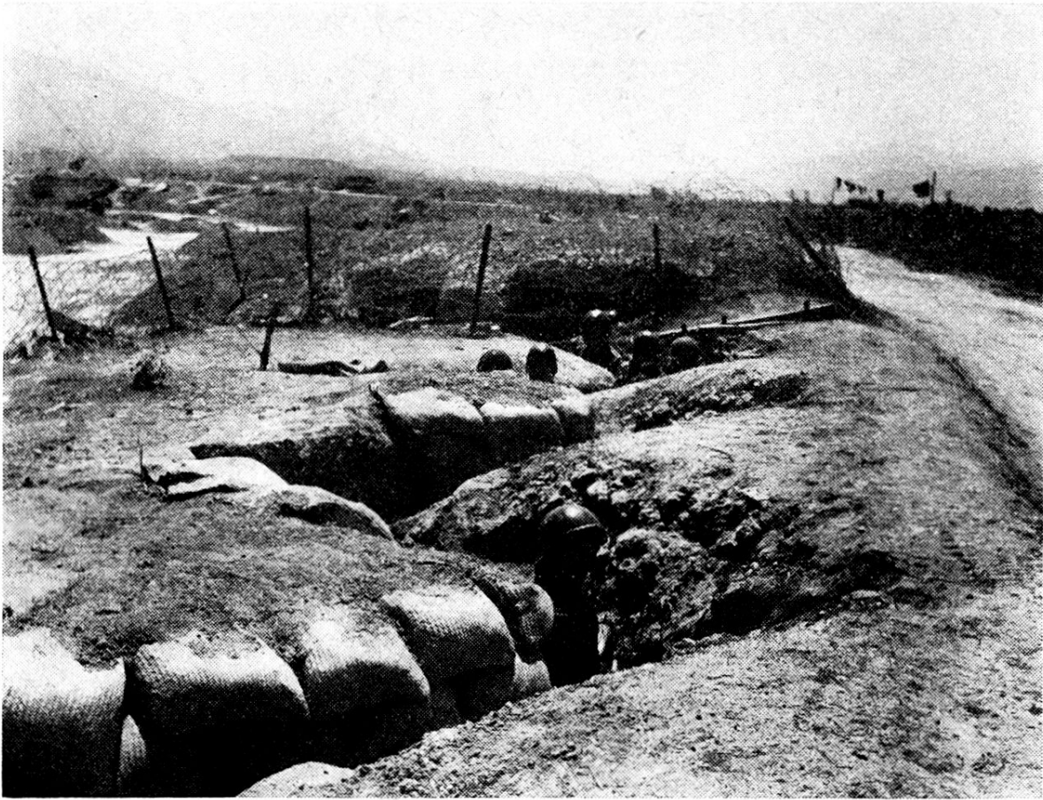
Détails de l'organisation défensive à proximité de la rivière Nam-Youm, qui traverse le camp. Un abri et un boyau en zigzag.
