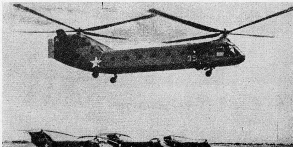
Russischer Großhelikopter Yakovlev «Yak 24». Nutzlast 4,5 t bzw. 40 Mann. Der Yak 24 befördert somit bei doppeltem Abfluggewicht die doppelte Nutzlast wie der ihm äußerlich ähnliche USA-Typ H 21 «Workhorse» (Vertol 44)
