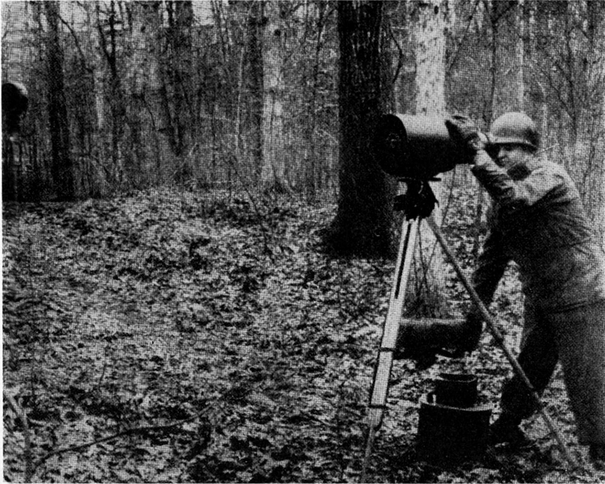
Fig. 5. Ein Beobachtungsgerät für den Bat.Kdt., das mit Infrarot arbeitet, gestattet die Nachtbeobachtung bis auf die Wirkungsdistanzen der organischen Bat.Waffen.
