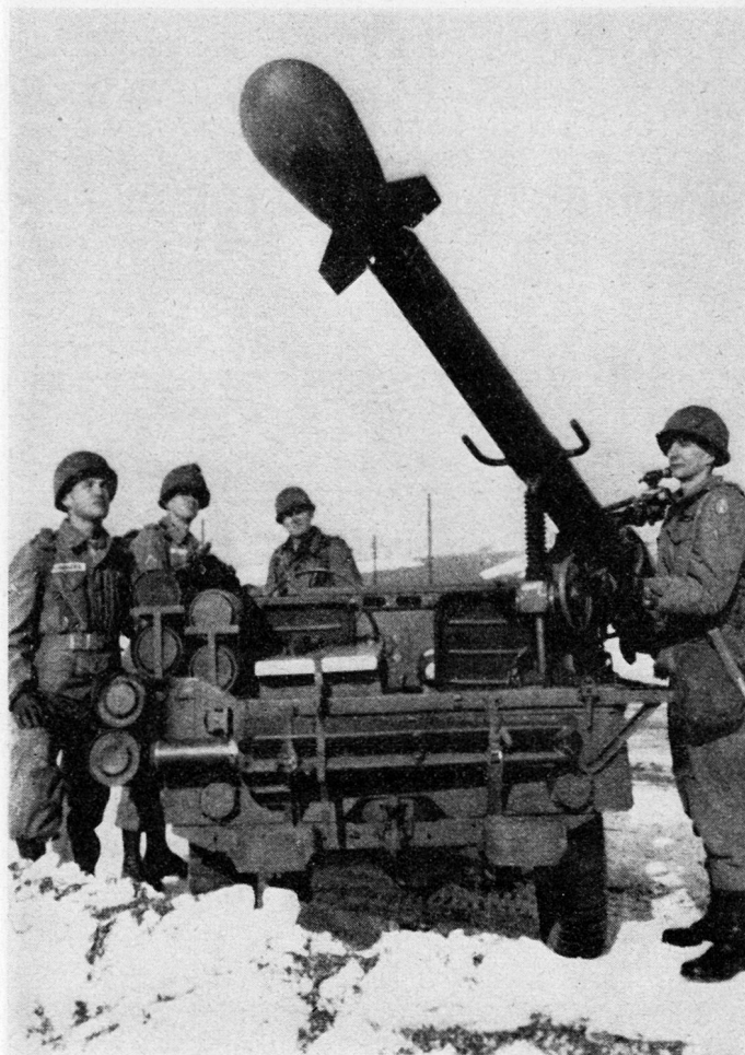
Unser Bild zeigt die zirka 75 cm lange und mit Stabilisierungsflächen versehene Infanterie-Rakete «Davy Crockett» auf ihrer einfachen Abschußvorrichtung
