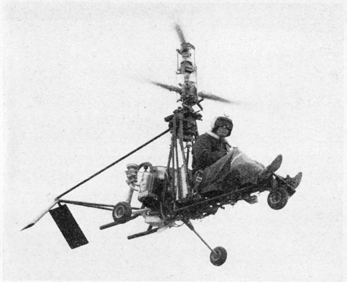
13. Versuchsmodell eines «Einmannhelikopters» (XRON-1)
