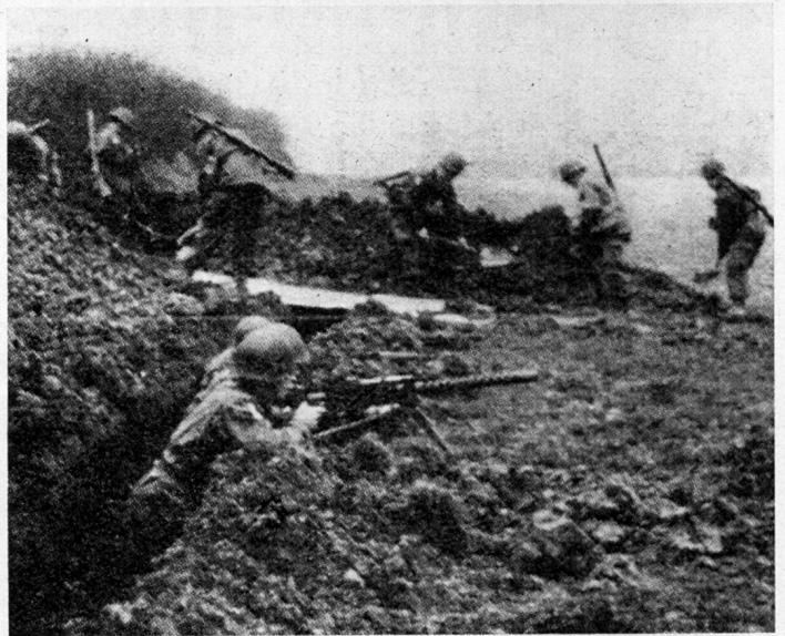
Bild 4. In 10 Minuten baut die Füsiliergruppe die Einheitsstellung zum Unterstand für 6 Mann aus, indem das T-förmige Grabenelement mit einer Zeltblache und 70 cm Erde bedeckt wird.
