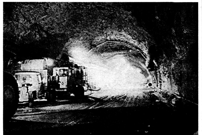
Bild 4. Ein Eingangstunnel zum NORAD-Hauptquartier im Cheyennegebirge während des Baus. Der Haupteingang ist 8,85 m breit und 7 m hoch. Das Werk hat 18 580 m 2 Bodenfläche.
