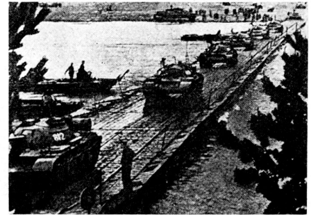
Bild 3. Die fertige Pontonbrücke PMP (150 m lang).
