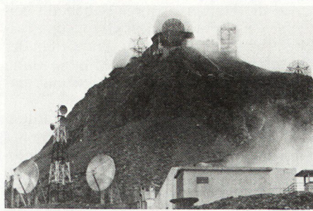
Bild 1. Eine Groß-Rundsicht-Radaranlage in einem spanischen Berggebiet.
