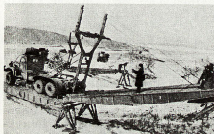
Bild 6. Vorbereitung des Brückenschlages über ein Wasserhindernis.
