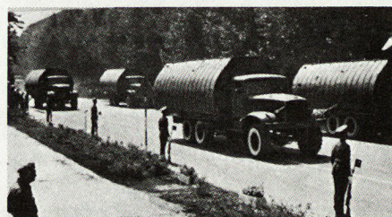
Bild 1. Vorbereiten des Hohlplatten-Faltbrückengeräts PMP für Brückenschlag. Klappontons werden herangefahren.
