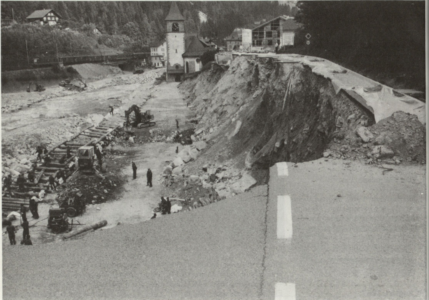
Eine grosse Schadenlage erfordert den Einsatz mehrerer Baumaschinen und vieler Wehrmänner einer Ls Kp ...
