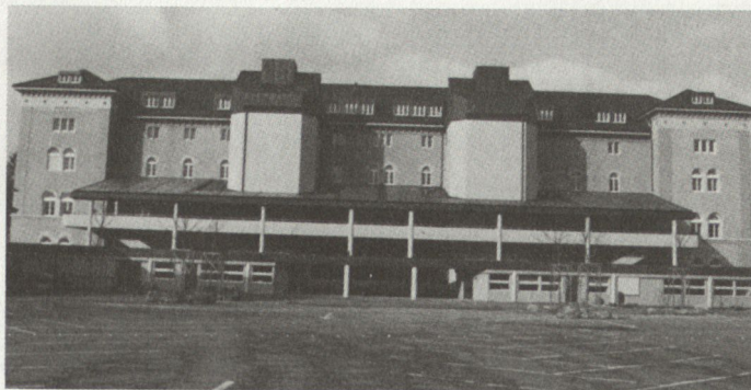
... während auf der Südseite (Kasernenhof) sogenannte Annexbauten mit Büros, Putzhallen und zwei Treppenhäusern die alten «WC-Türme» ersetzen.
