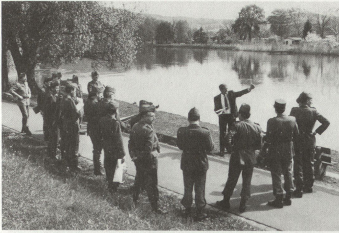
An der Limmat in der Nähe des Bahnhofs Dietikon: Hier wurde unter grösster Geheimhaltung die Überquerung der Limmat vorbereitet.
