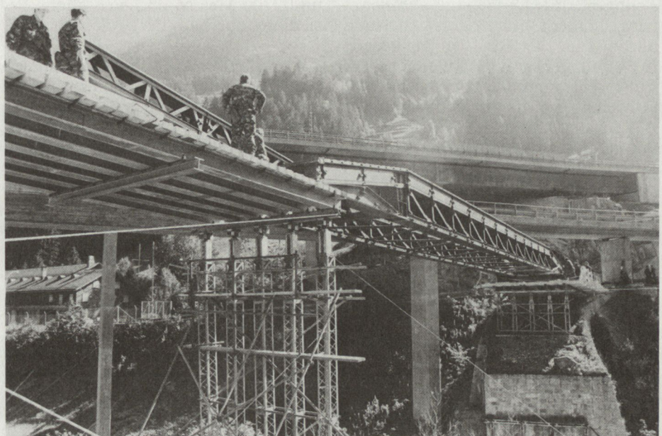
Genie. Brückenschlag bei Wassen.
