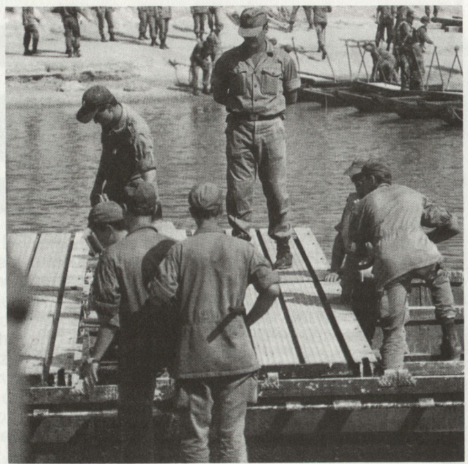
Griechische Pontoniere an der Arbeit: Die Metallfahrbahn wird auf eine Schwimmbrücke gesetzt. Im Hintergrund ein Steg im Bau.
