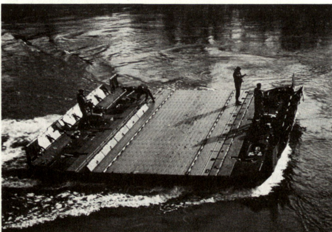
Schwimmbrücke 95. Verschieben des eingewässerten Moduls an die Brückenbaustelle.
