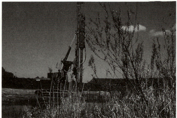
Abb. 3: Das Rammen von Pfählen (hier mit Ramme auf Raupenfahrzeug) als Voraussetzung zum Brückenbau. (Armee-fotodienst)
