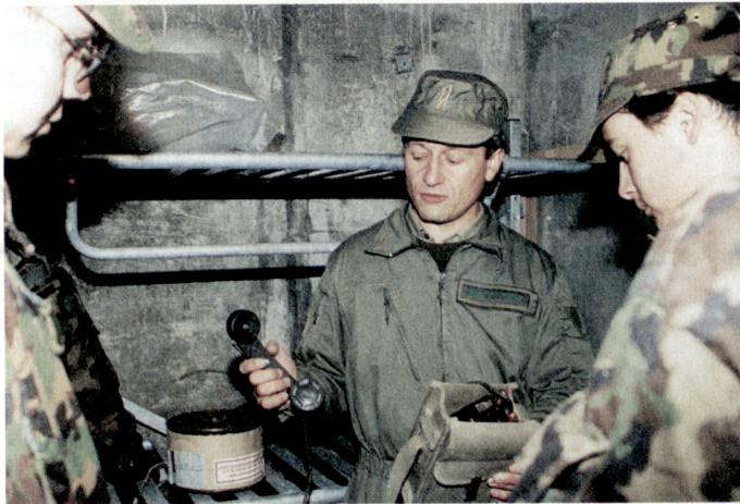
Instruktion der Truppe im Anlagenbetrieb.
