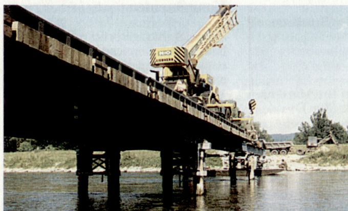
Stahlträgerbrücke mit Komponenten
