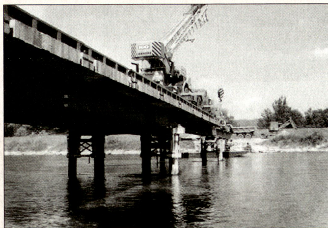
Stahlträgerbrücke des G Bat.
