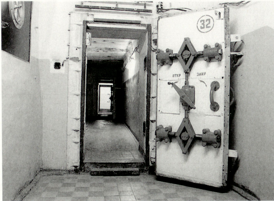
Eingang zum Nachrichtenteil der unterirdischen Kommandozentrale der Gruppe Sowjetischer Truppen in Deutschland in Wünsdorf-Zossen, südlich von Berlin. Diese Anlage diente ursprünglich der deutschen Wehrmacht, wurde dann in den 60er-Jahren durch die Sowjets umgebaut. Heute ist diese Anlage als Teil eines Museums zu besichtigen.
