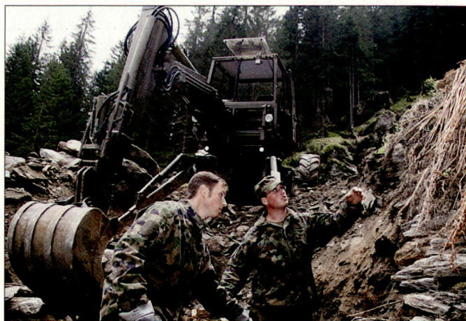
Lavori di consolidamento e di messa in sicurezza della strada.
