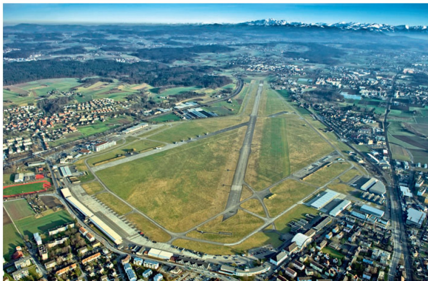
Militärflugplatz Dübendorf – der wichtige Stützpunkt der Luftwaffe in der Ostschweiz.
