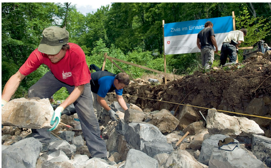
Zivildienstleistende beim Bau von Trockenmauern. Foto: P. Schneider, Thun
