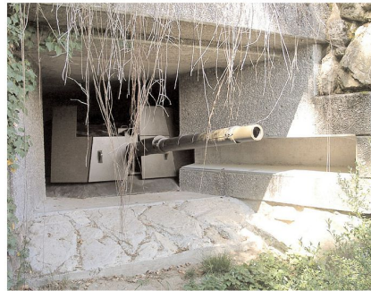
Neueste Anlage: «Centurion-Bunker» im Löwenberg bei Murten. Am Ende des Kalten Krieges erstellt. Turm des Centurion Panzers mit Zusatzpanzerung und Kanone in Feuerstellung. Bild: Marc Ramel, Appenzell
