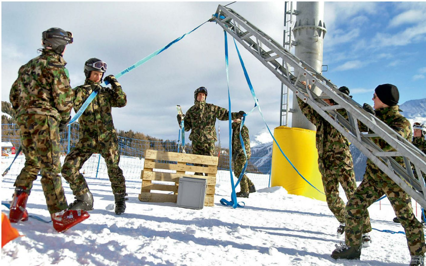
Gemeinsam anpacken: Angehörige der Pz Mw Kp 28/5 helfen bei den Aufbauarbeiten für die Ski-Weltcuprennen der Damen.
