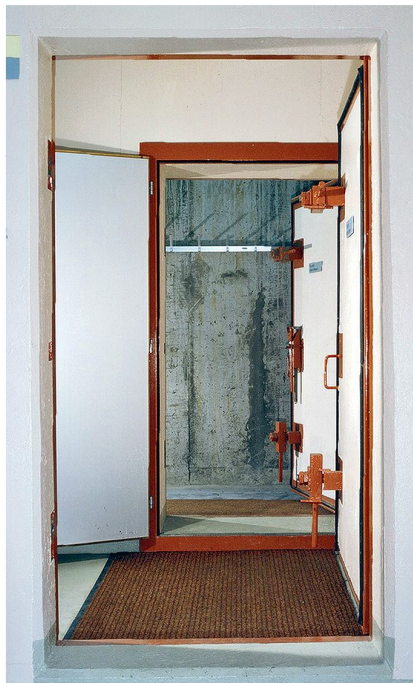
Schutzräume: Für den Krieg gebaut – und für mögliche Notfälle unersetzlich. Foto: BABS
