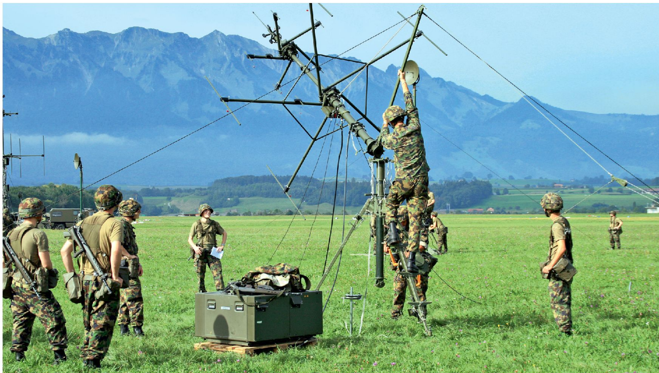
Soldaten der EKF Abteilung 51 beim Errichten einer Peilantenne.
