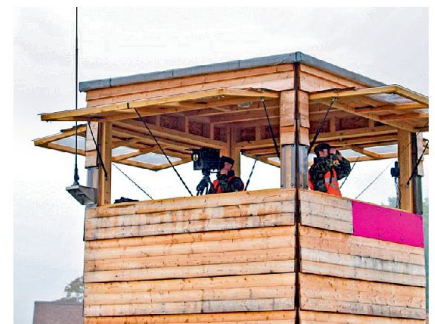
Das Dispositiv AERO SUBITO umfasst Kontrolltürme mit leistungsfähigen Beobachtungs- und Übermittlungsmitteln.
