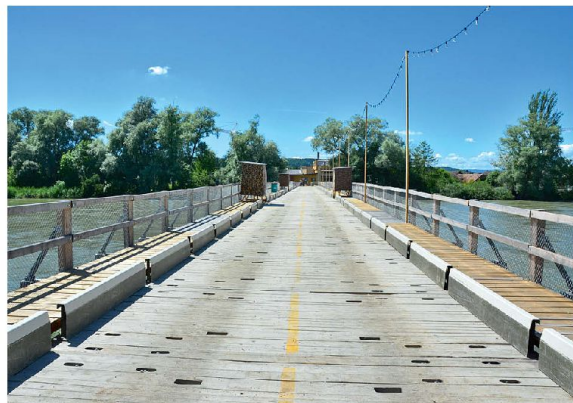
Abb. 1: Stahlträgerbrücke, zivilgängig. Bilder: Kdo LVb G/Rttg
