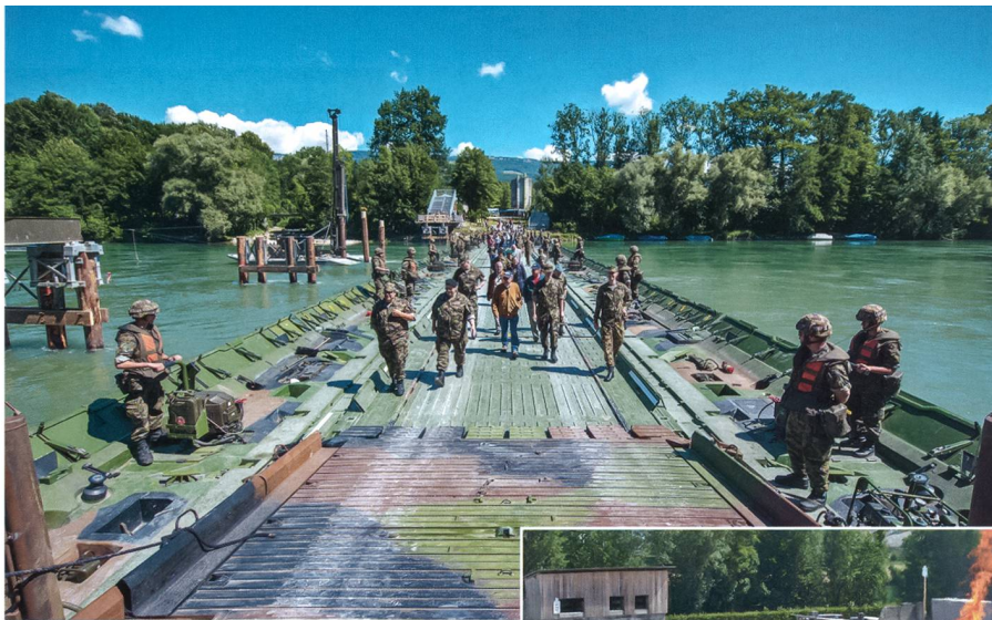
Die Pontoniere haben die Schwimmbrücke zusammengefügt. Bild: ZEM-VBS
