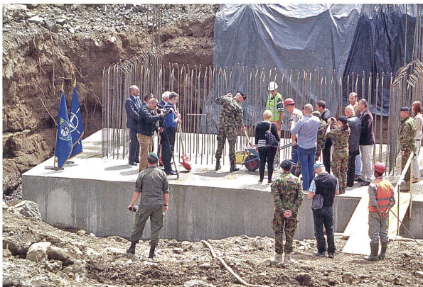
Abb. 3: Der COM JRD-N, Oberst Reto U. Flühmann, zusammen mit den kosovo-serbischen Bürgermeistern bei der Grundsteinlegung für eine neue Brücke (18. Mai 2016).
