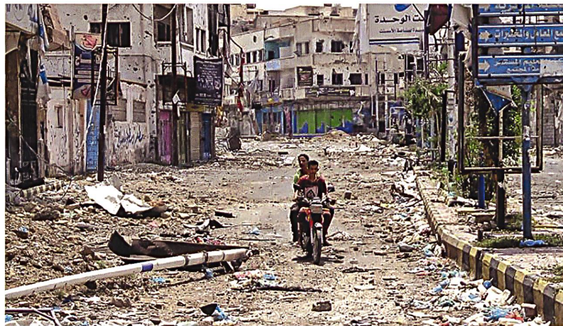
Zerstörter Strassenzug in Taiz.
