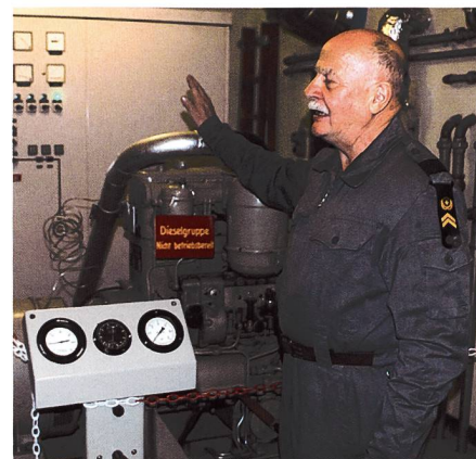
Fritz Gehring und seine Helfer bauten die KP-Einrichtung samt dem Maschinenraum wieder originalgerecht auf.
