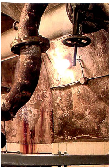
Abbildung unten: Artilleriewerk Michelsberg, Kraftwerk.
