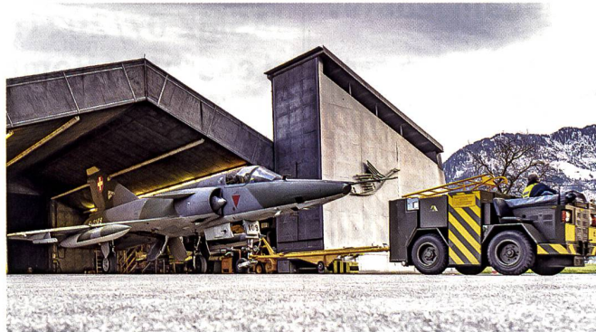
Das 1967 auf dem Flugplatz Buochs erstmals in Betrieb genommene «Bremshaus» ermöglicht Tag und Nacht Testläufe ohne Lärmbelastung der Bevölkerung sowie gute Arbeitsbedingungen für das Personal.
