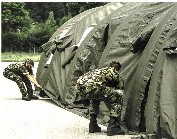
◀ Der mobile KP wird aufgebaut.
