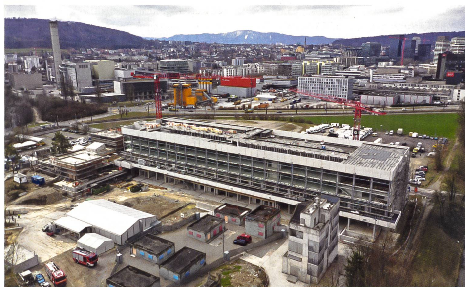
Der Bau des Bildungszentrums Blaulicht ist weit fortgeschritten und wird im Frühling 2023 eröffnet.
