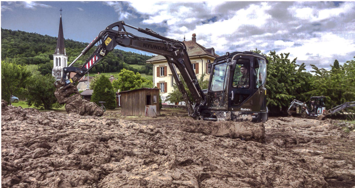
Ein Geniebataillon half nach den Überschwemmungen in Cressier (NE) bei den Aufräumarbeiten.
