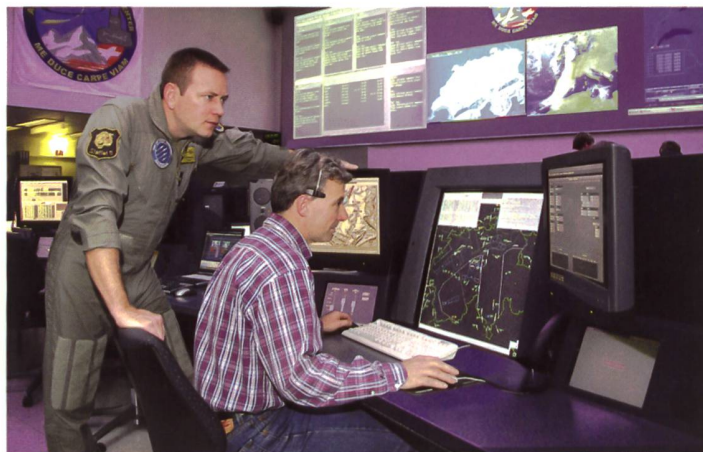
Dieses 2011 entstandene Bild zeigt die militärische Flugsicherung im neuen Skyguide-Gebäude auf dem Flugplatz Dübendorf. Bild: Luftwaffe
