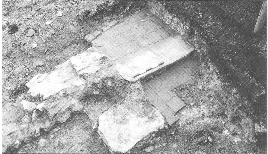
Abb. 8 Erschwil/Kirchgasse 54 (Scheuernmatt). Nordöstliche Mauerecke des älteren Chors. Links der Eingang in die Sakristei. Rechts der jüngere Chorboden. Gegen Nordosten.
